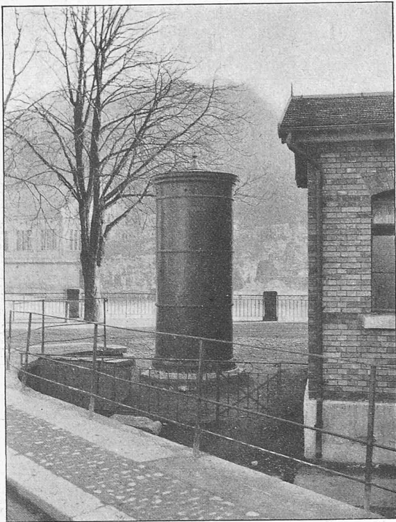
Fig. 14. Transformatorstation für unterirdische Primär- und Sekundärleitung.
