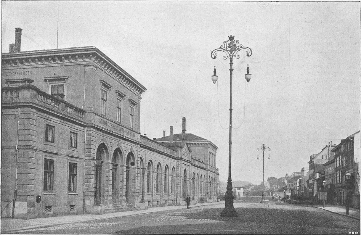
Fig. 22. Bogenlampen-Kandelaber auf dem Bahnhofplatz.
