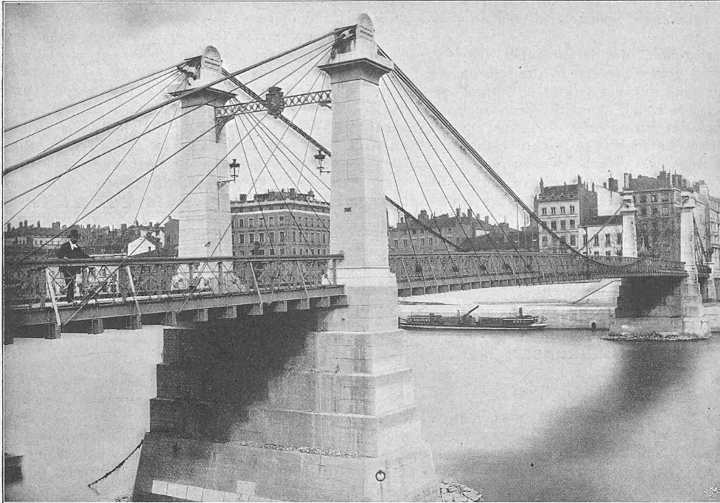
Fig. 18. Hängebrücke du Midi in Lyon.
