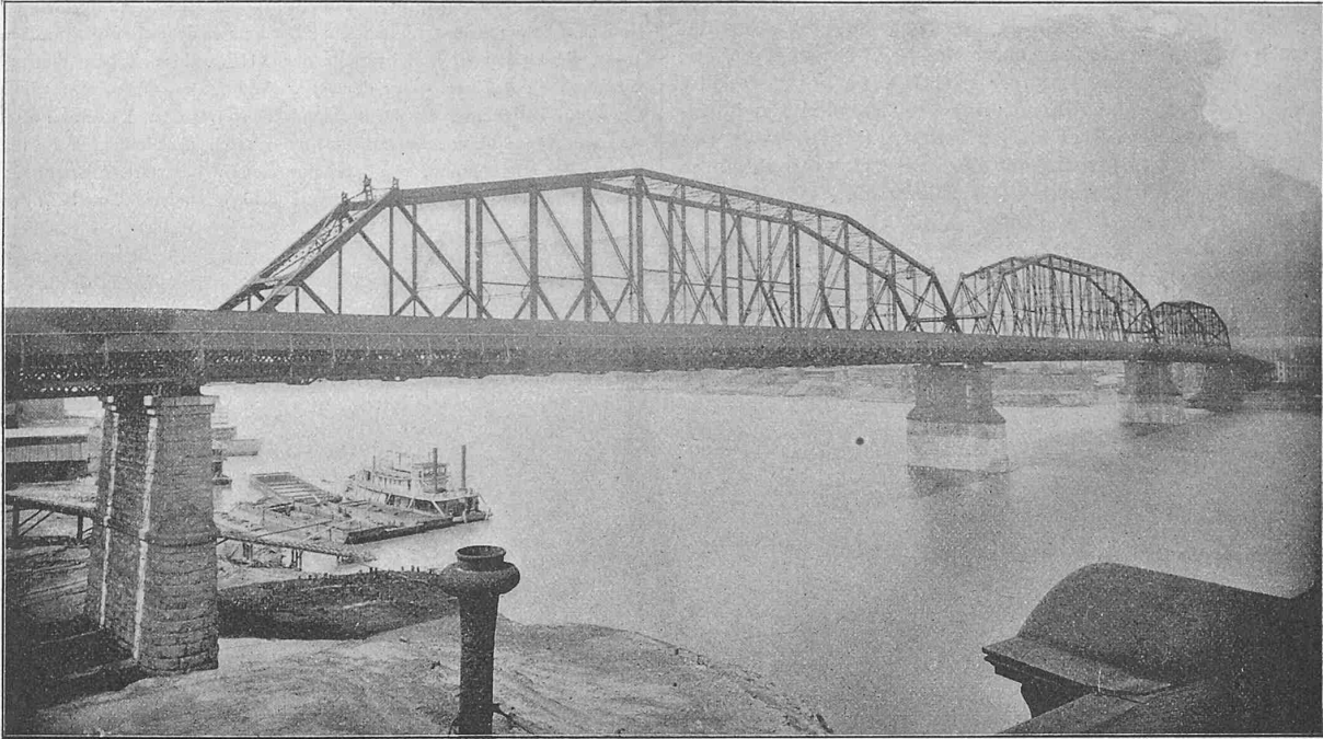
Fig. 25. Ohio-Brücke der Cincinnati-Covington-Eisenbahn.
