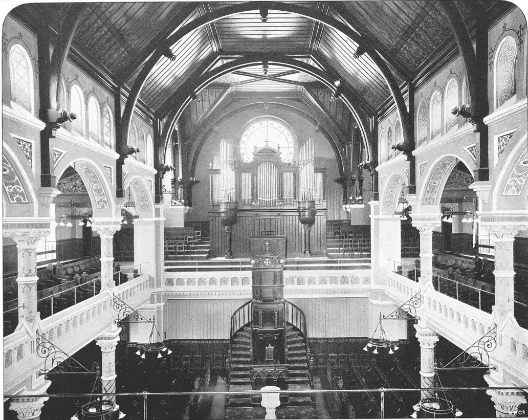
Innen-Ansicht der Johannes-Kirche in Aussersihl-Zürich (Industrie-Quartier).
