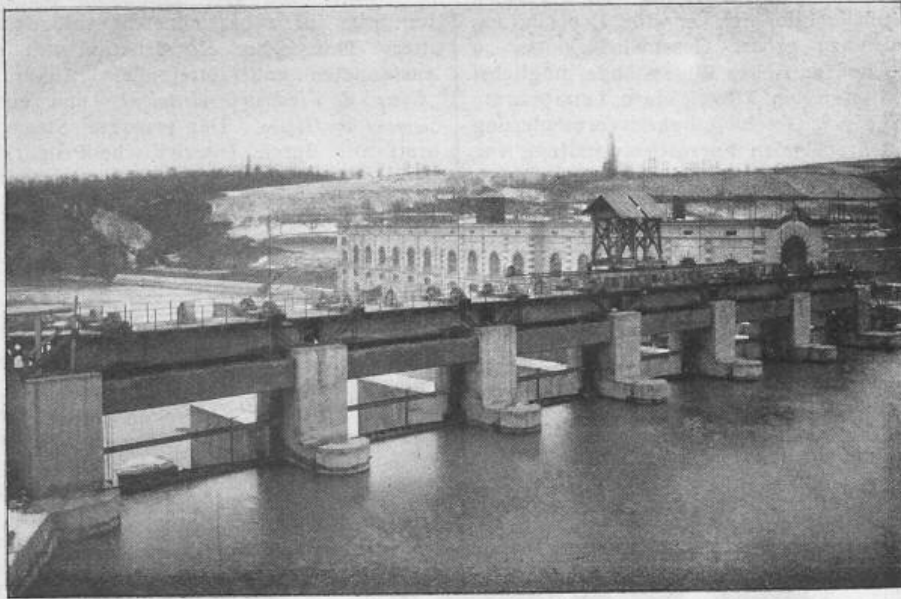
Fig. 2. Elektrizitätswerk Chèvres bei Genf. — Wehranlage.
