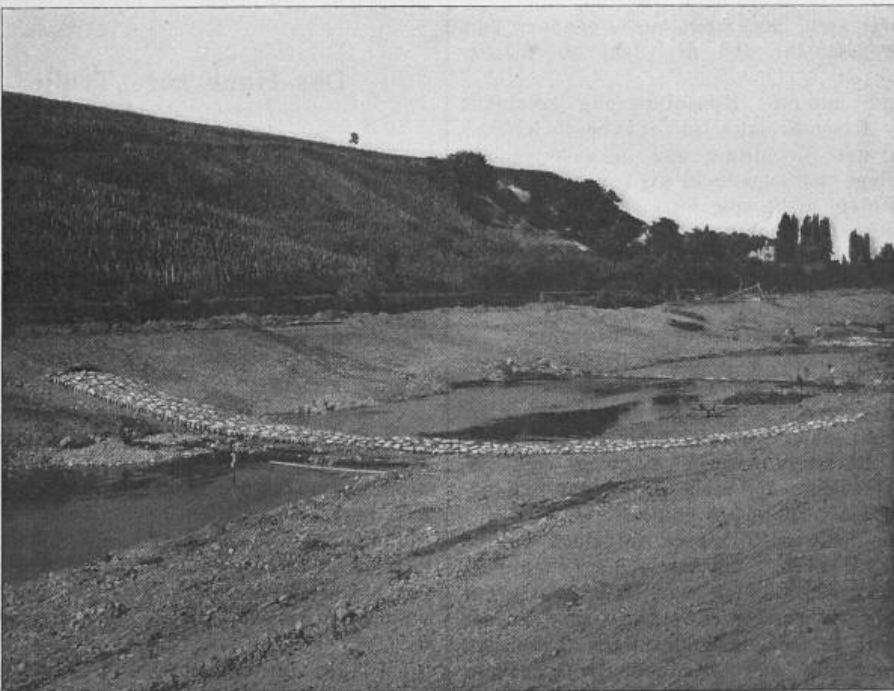
Fig. 8. Vordergrund mit Faschinenunter- und Oberbau fertig zur Berasung. Das folgende Feld: Faschinenunterbau, Anschluss an Gürtelunterbau.
