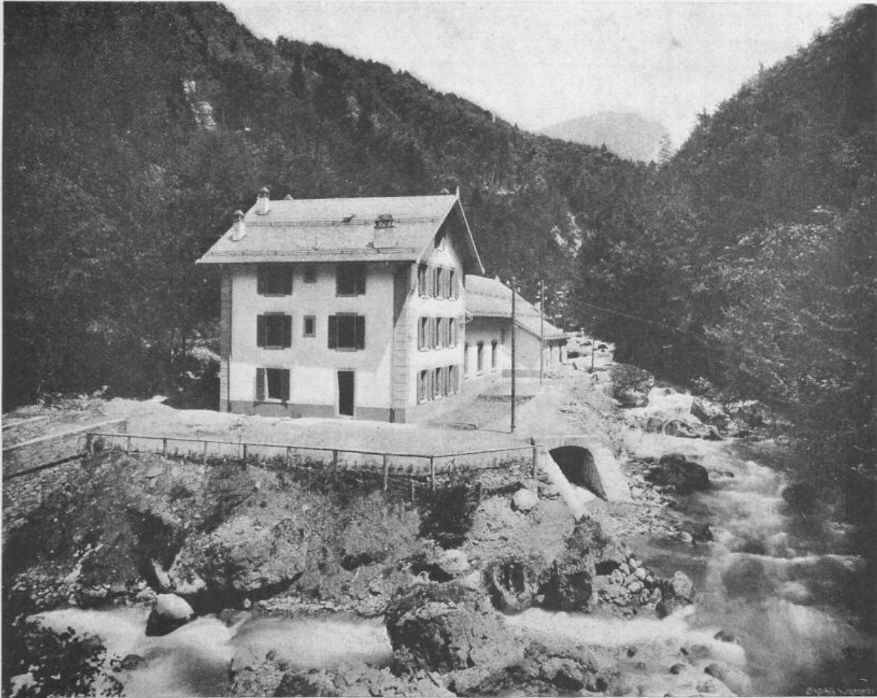
Fig. 12. Ansicht des Maschinenhauses.
