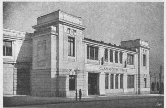
Fig. 6. Wiener Stadtbahn. Haltestelle Gumpendorfer-Strasse.
