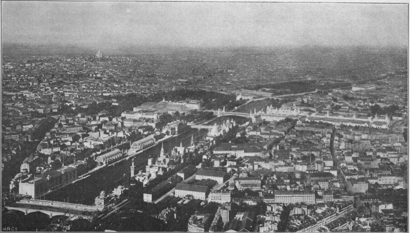
Gesamtansicht der Bauten vom Haupteingang bis zur Alma-Brücke.
