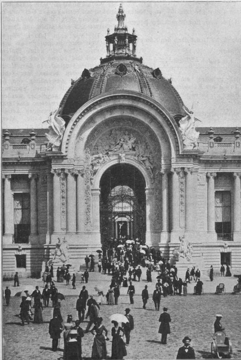
Fig. 17. Kleiner Kunstpalast. — Hauptportal. — Arch. Ch. Girault.
