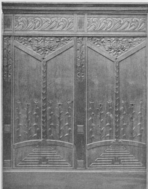
Fig. 4. Wandbekleidung mit Koptoxyl in Reliefpressung.
