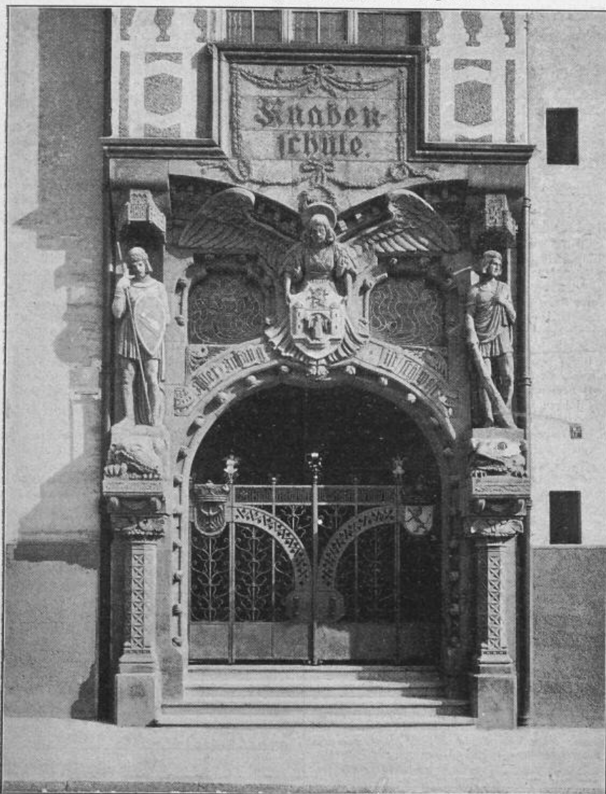
Fig. 5. Schulhaus in der Vorstadt Schwabing. — Portal. Architekt: Theodor Fischer; Bildh.: J. Flossmann in München.
