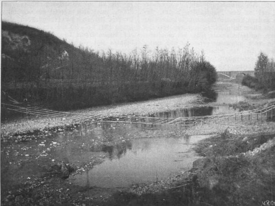
Fig. 1. Darstellung des bisherigen Trapezprofils und des neuen Ovalprofils durch Lattenfigur.
