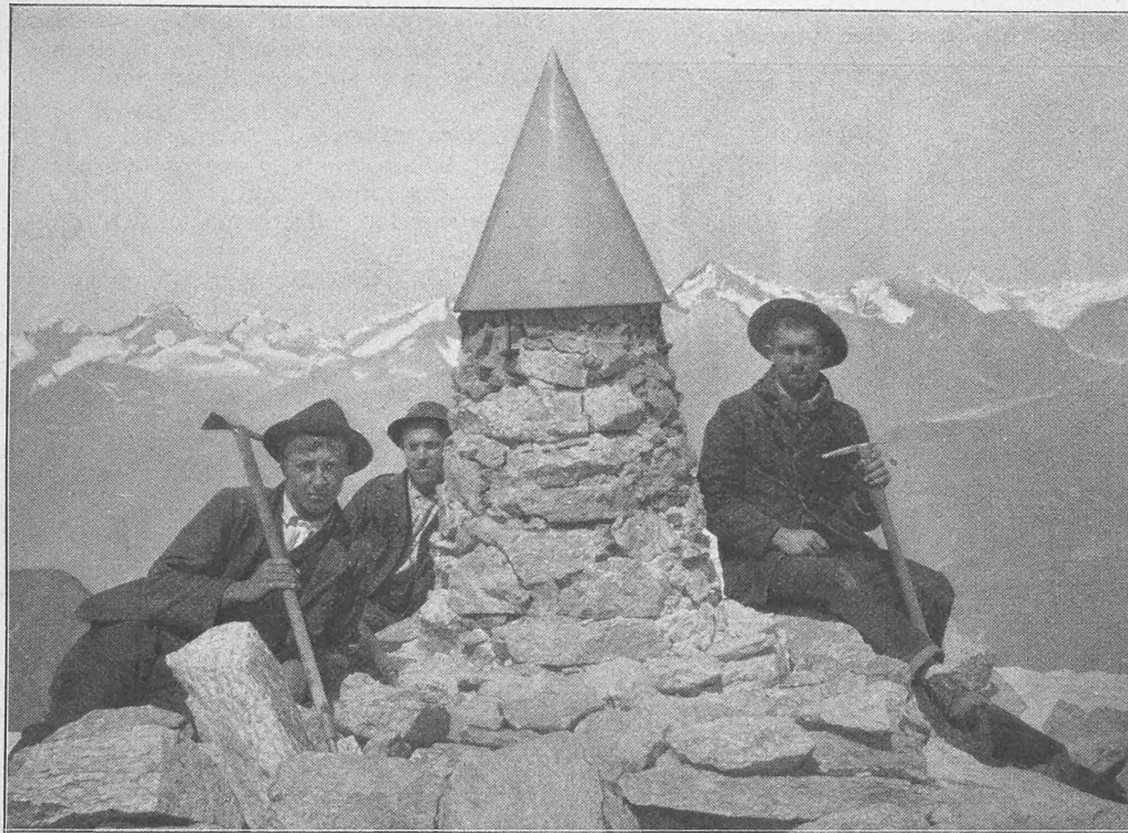
Fig. 6. Trigonometrisches Signal auf dem Monte Leone.
