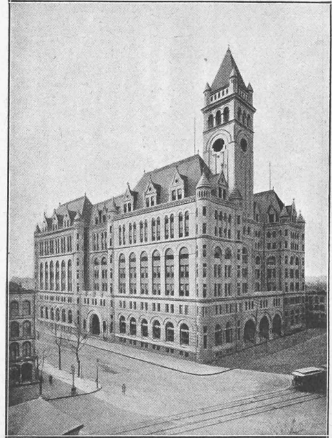
Abb. 36. Washington. — Das Postgebäude.
