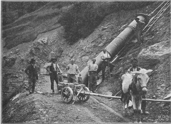
Abb. 12. Transport der Rohre.
