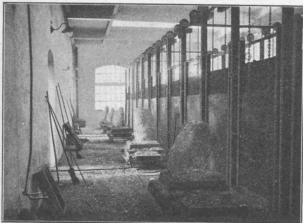
Abb. 32. Carbidgefabrik. — Der Kühlraum.
