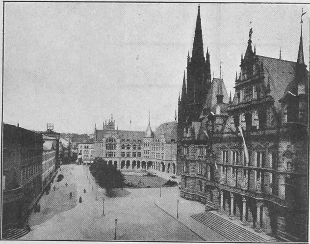
Abb. 1. Schlossplatz zu Wiesbaden. — Ansicht von Südwesten.
