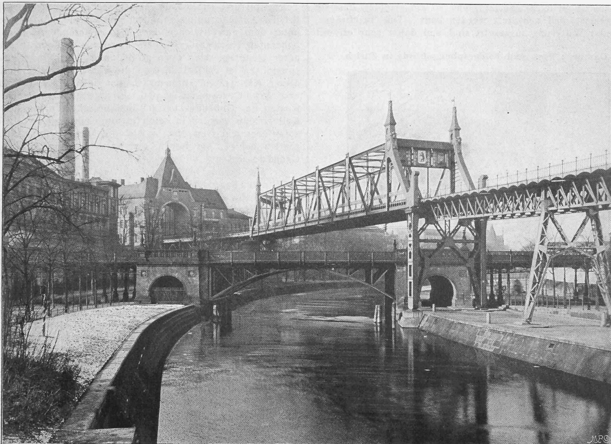
Abb. 15. Ueberbrückung des Landwehrkanals und der Anhalterbahn.
