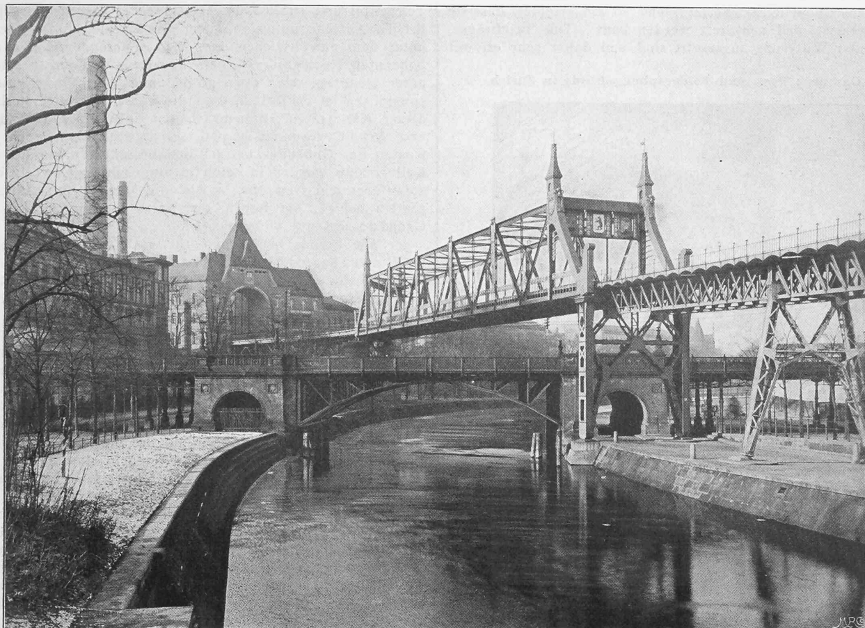
Abb. 15. Ueberbrückung des Landwehrkanals und der Anhalterbahn.
