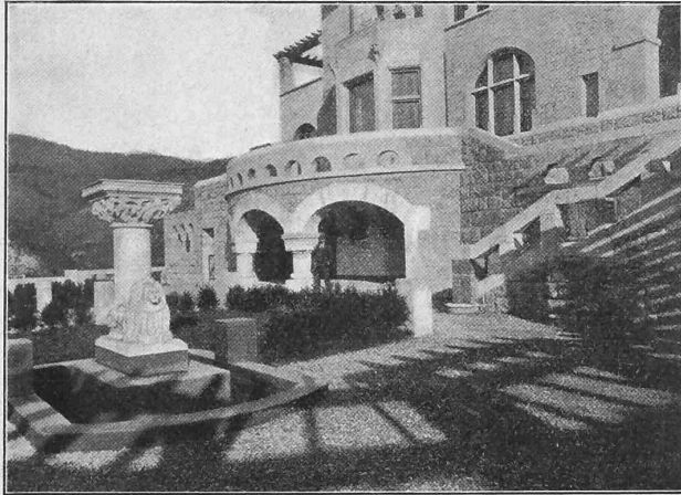
Abb. 6. Westseite; untere Terrasse mit Brunnen.
