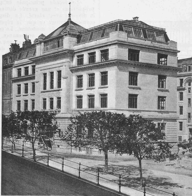
Fig. 1. Ecole des Beaux-Arts à Genève. Architectes: MM. De Morsier frères & Weibel. Vue depuis le Boulevard Helvétique.
