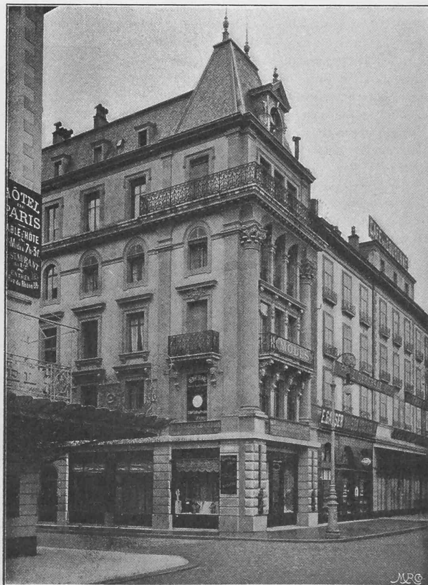
Fig. 33. Maison angle de la rue Céard et du Grand Quai.
