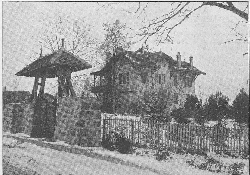
Fig. 47. Villa Penard à Grange Colomb. — Architectes: MM. L. & Fr. Fulpius.
