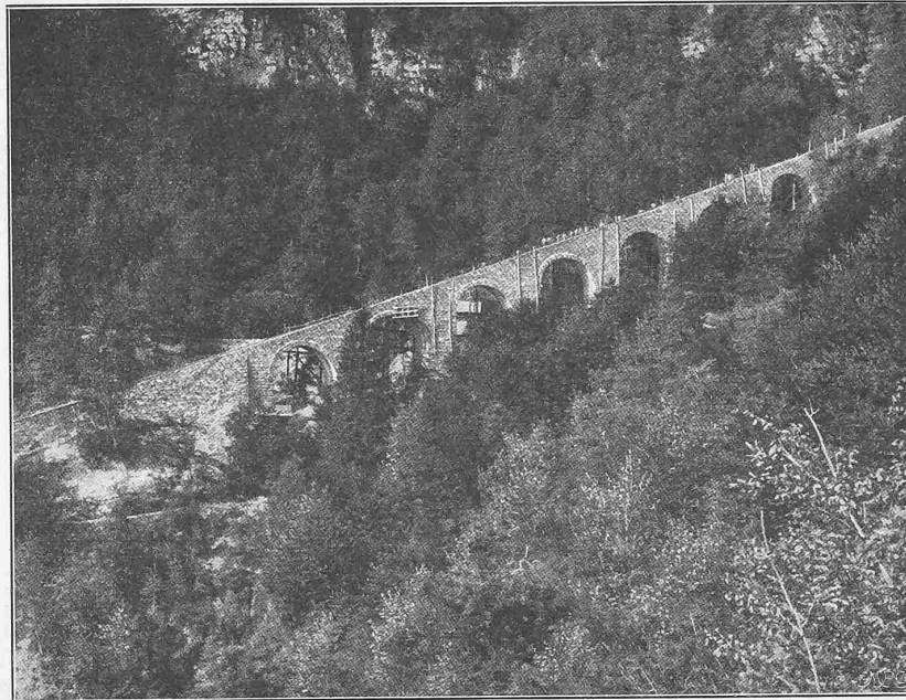
Abb. 12. Seitenansicht des grossen Viaduktes der Seilbahnstrecke.
