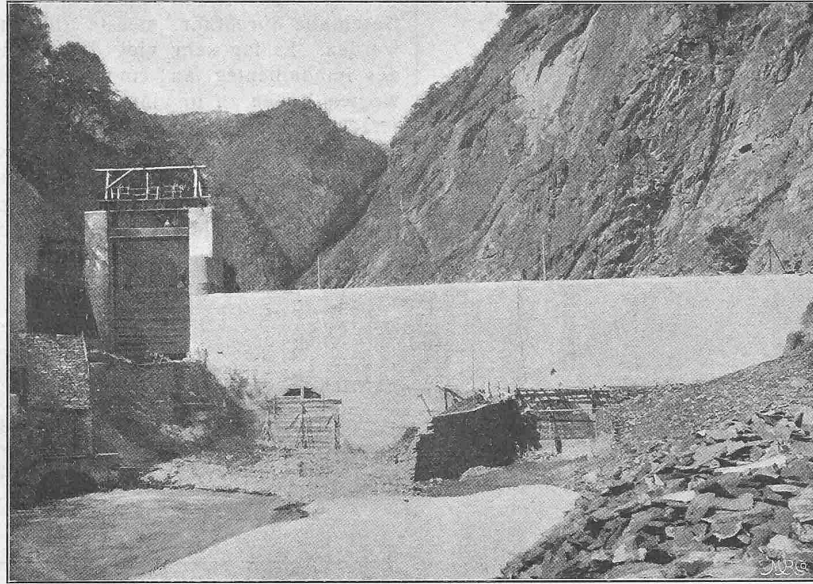
Abb. 12. Die Talsperre vor ihrer Vollendung im August 1902. — Ansicht flussabwärts.
