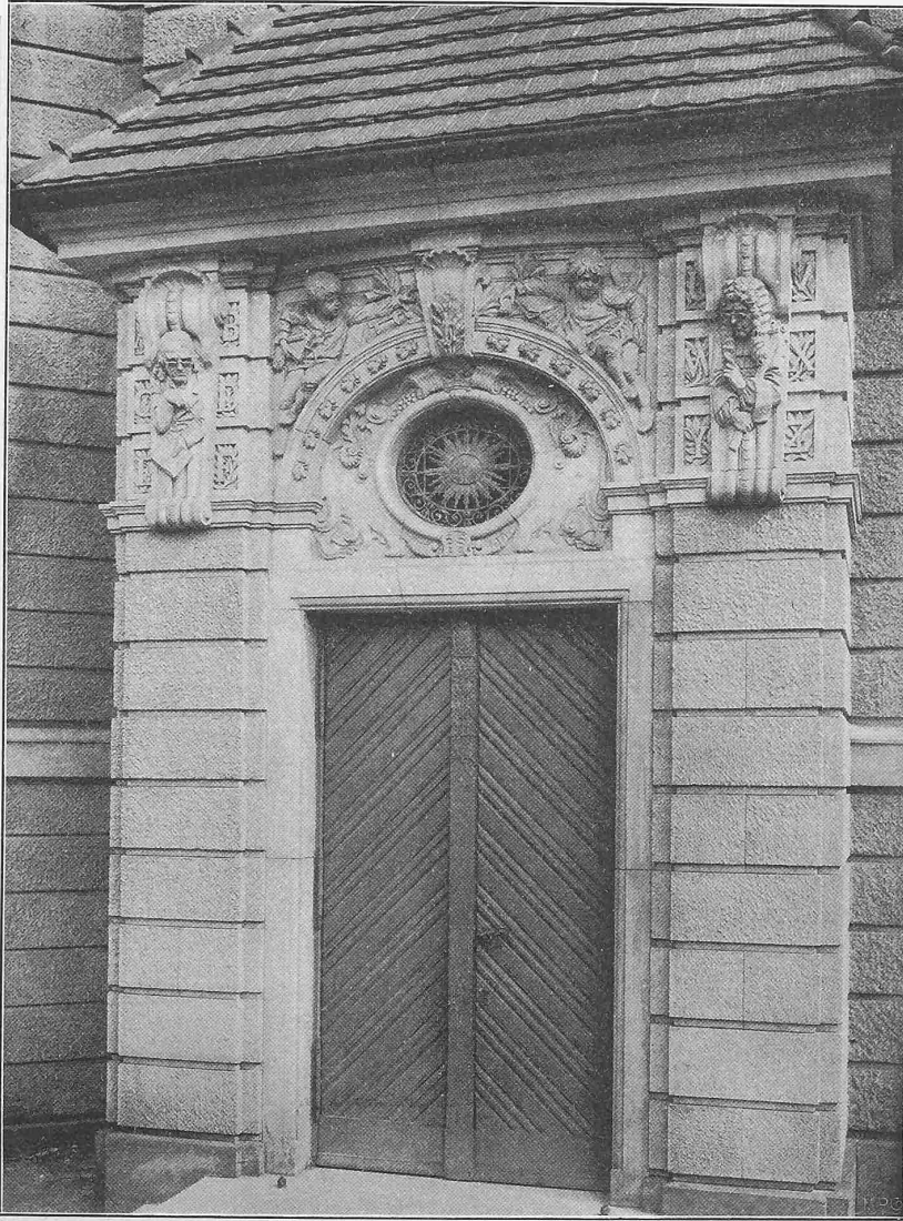
Abb. 13. Knaben-Portal der Gemeindeschule in der Wilmsstrasse. Erbaut von Stadtbaurat L. Hoffmann in Berlin.
