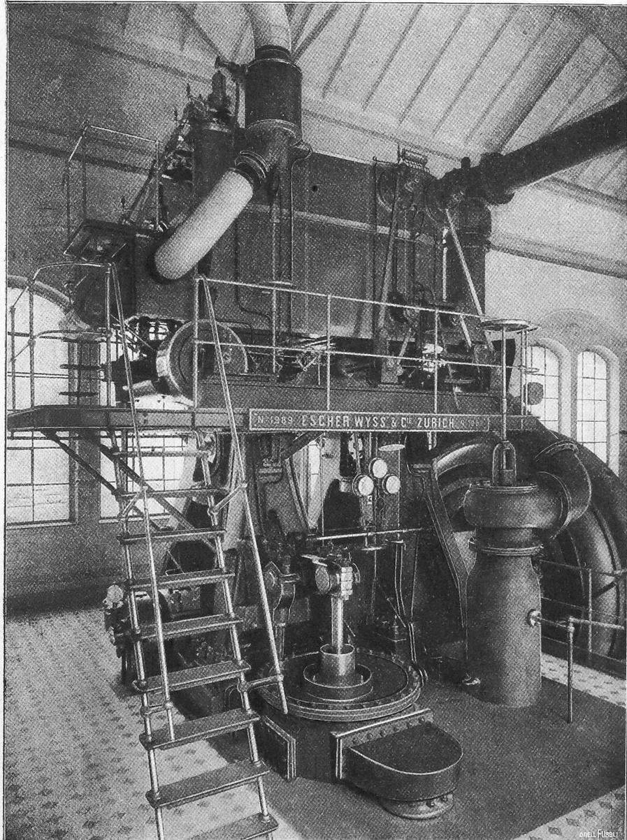
Abb. 43. Die 1000 P. S. stehende Maschine der Dampfreserve.
