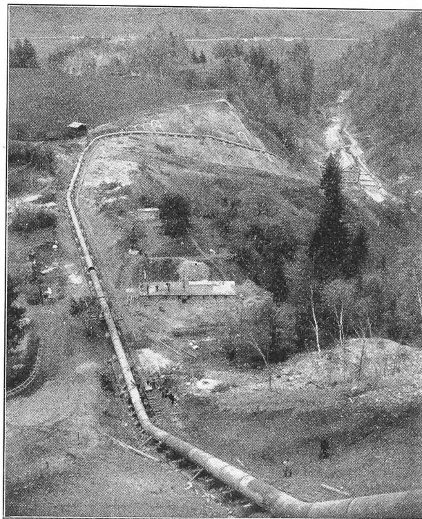
Abb. 2. Ansicht der Druckrohrleitung von oben.
