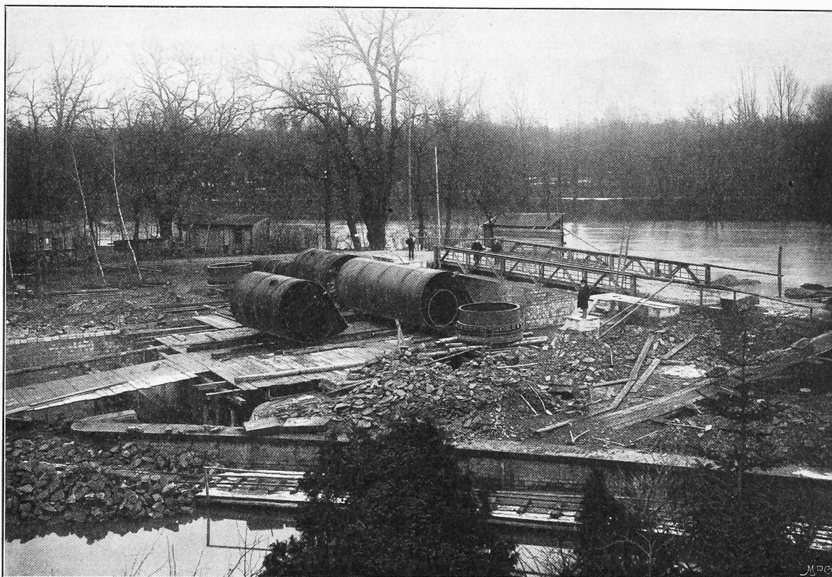
Abb. 6. Das Walzenwehr des Grundablasses bei Schweinfurt am Main während der Montage.
