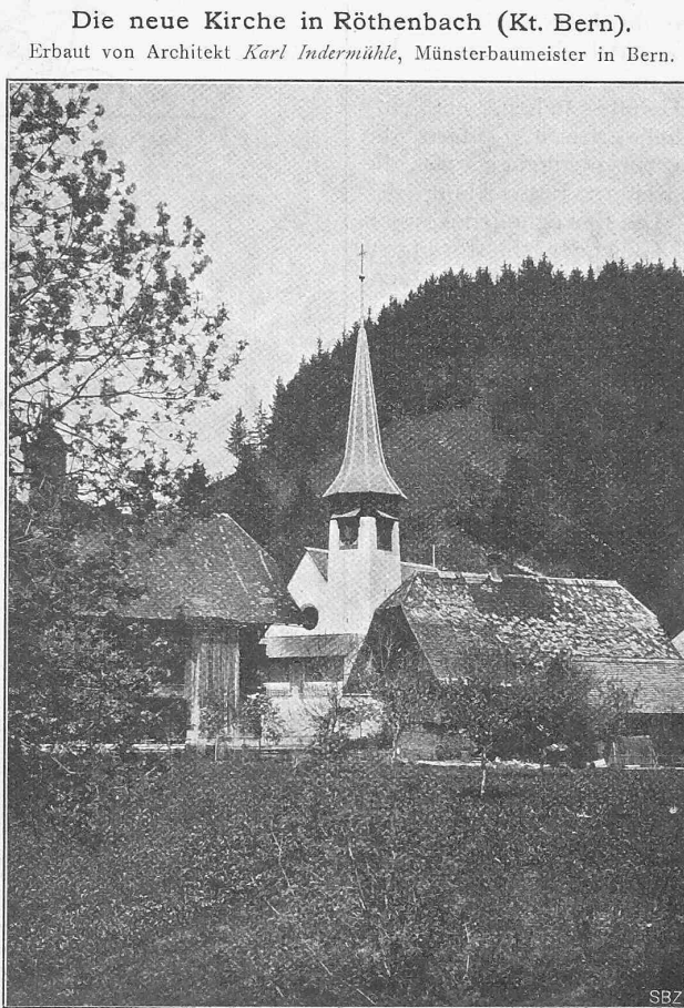
Abb. 7. Ansicht von Süd-Osten.
