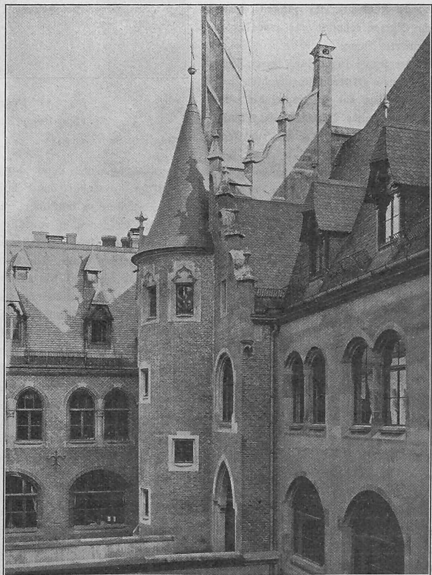
Abb. 12. Blick auf das Treppentürmchen des Kassenhofs.
