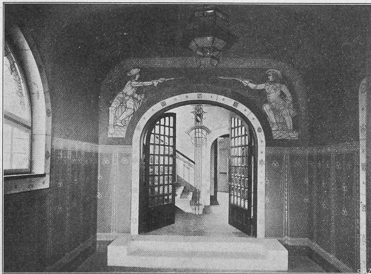
Abb. 4. Portal aus der Vorhalle in das Treppenhaus.
