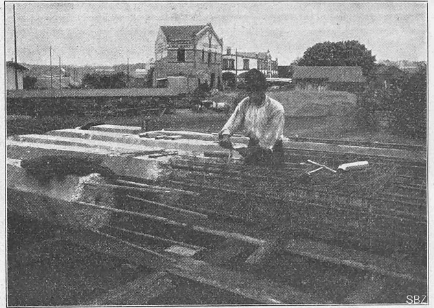
Abb. 24. Aufstücken von Hennebique-Pfählen.
