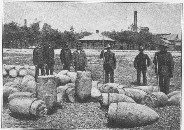
Abb. 42 Pfahlspitzen aus mit Streckmetall armiertem Beton.
