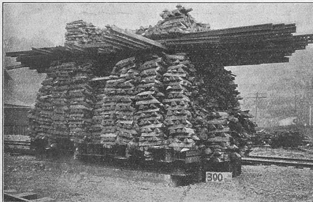
Abb. 50. Probelastung von «Simplex»-Pfählen.
