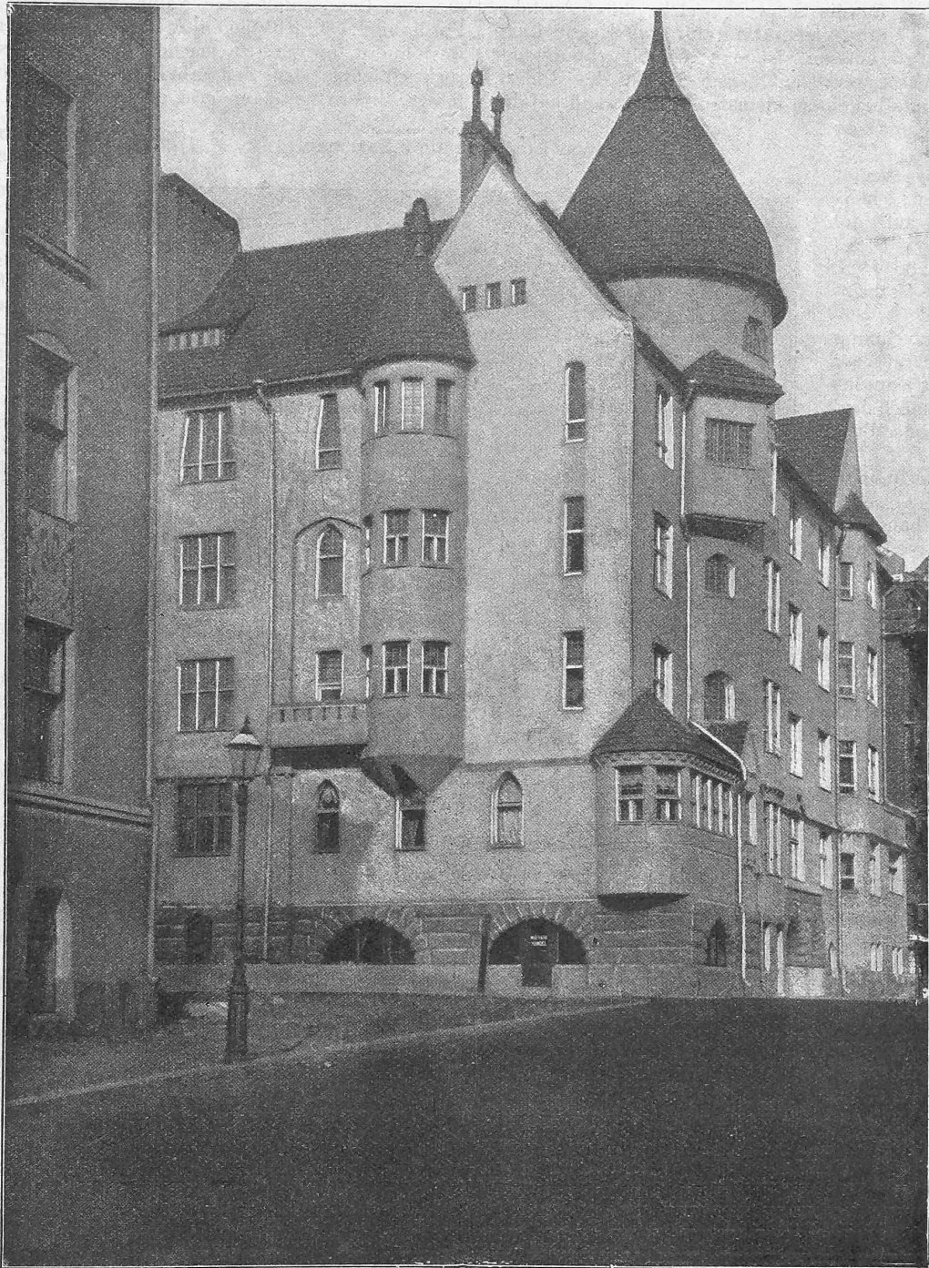
Abb. 5. Ansicht eines Wohn- und Geschäftshauses.
