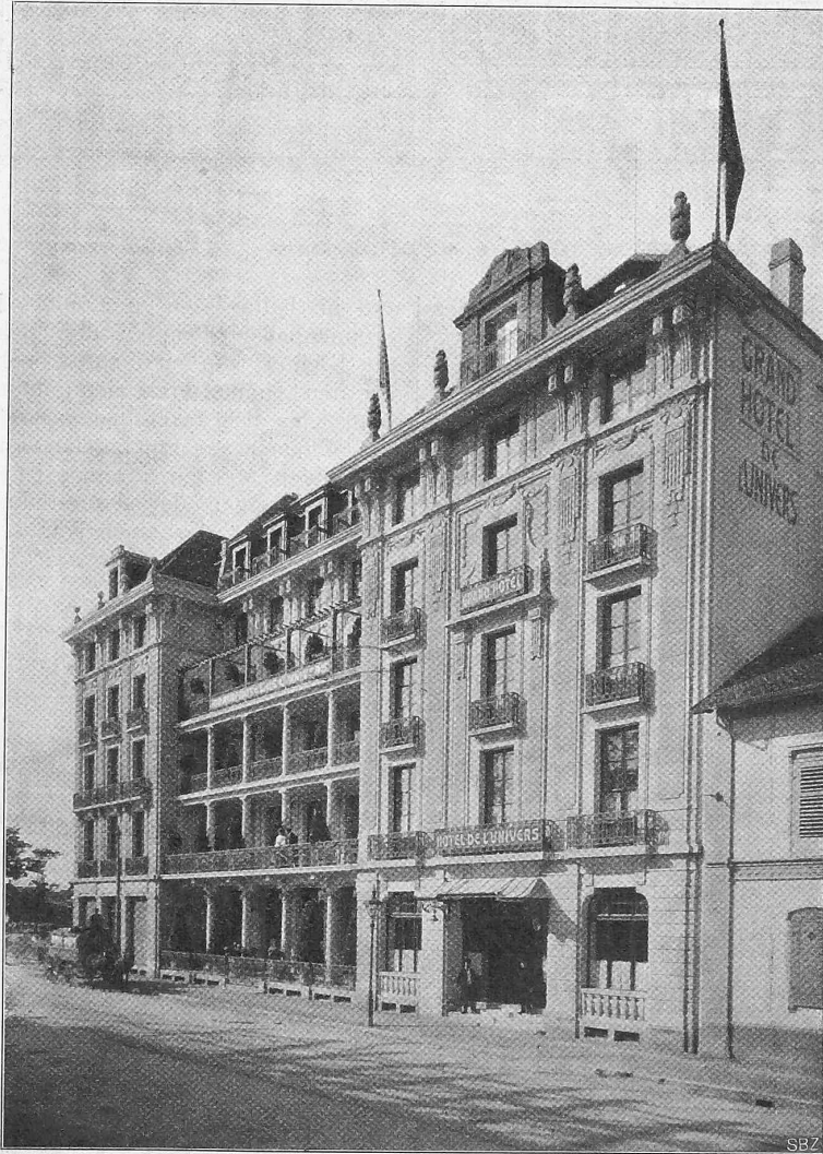
Abb. 1. Ansicht der Fassade an der Zentralbahnstrasse.
