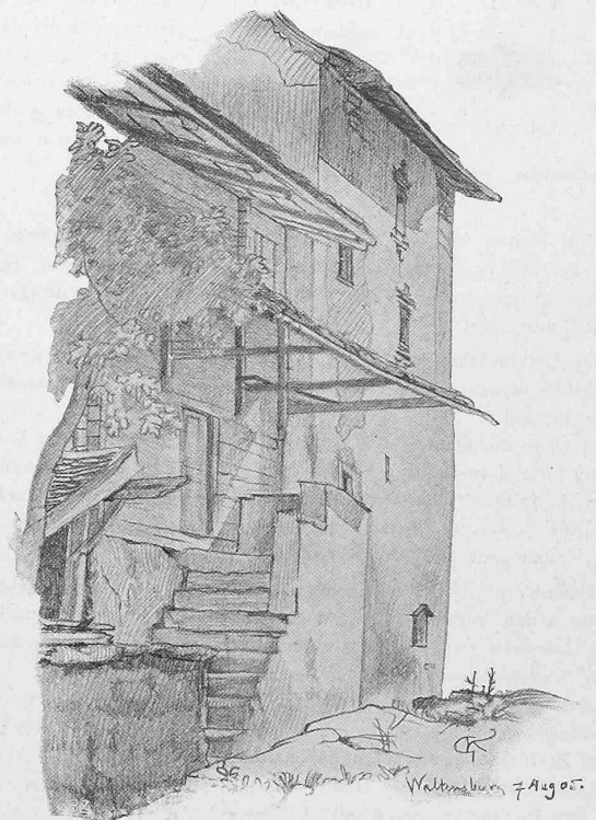
Abb. 8. Altes Haus in Waltensburg.
