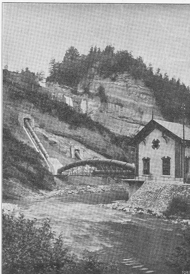
Abb. II. Ansicht des Maschinenhauses mit der zweiten Druckleitung.
