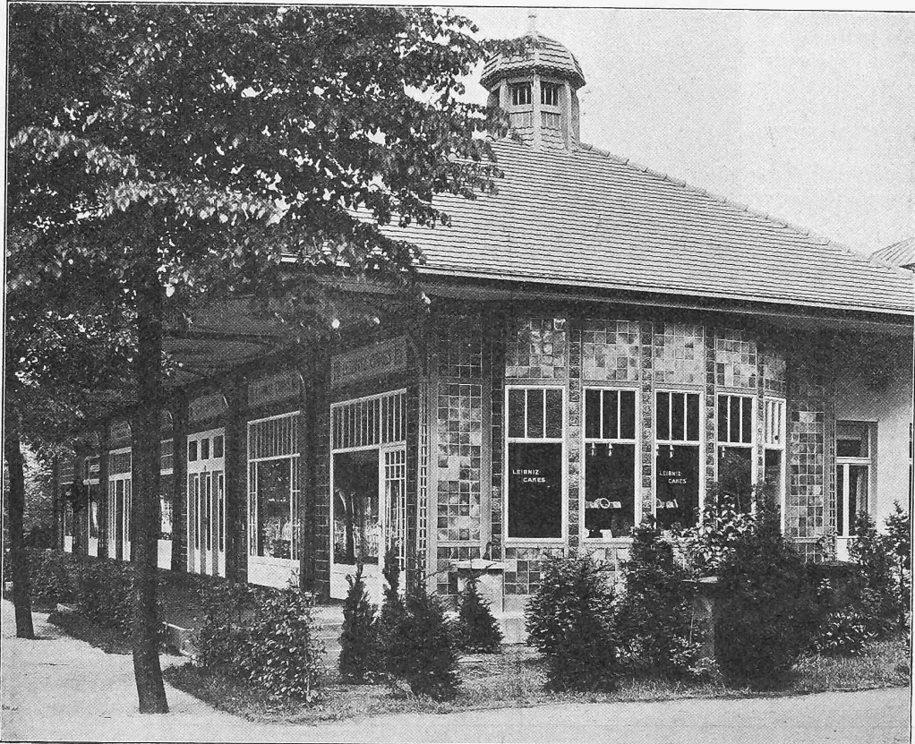
Abb. 27. Ladeneinrichtungen in Eisenkonstruktion mit Wandverkleidungen in farbigen Fliesen. — Architekt Prof. Fritz Schuhmacher in Dresden.
