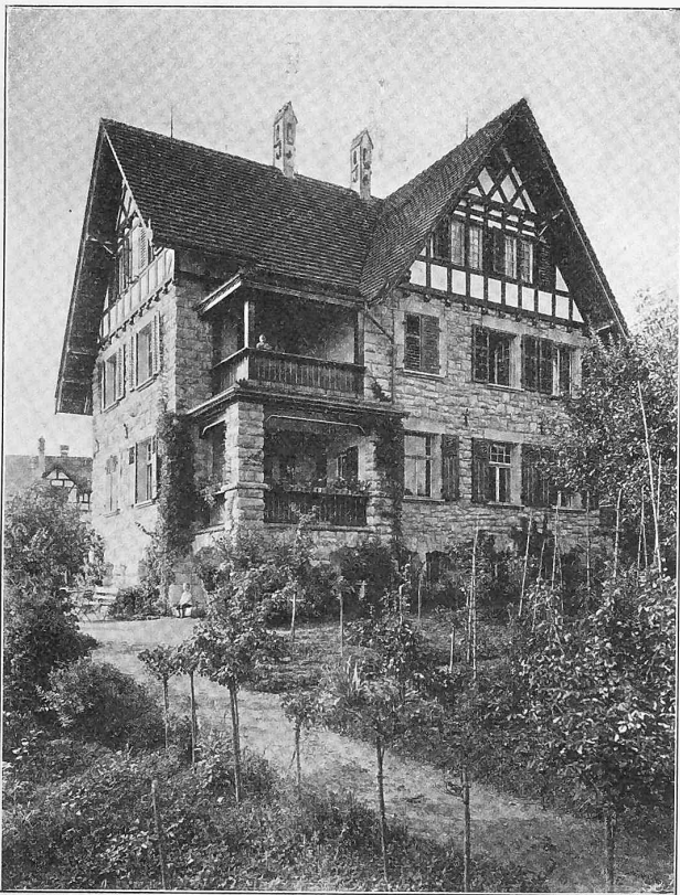
Abb. 1. Wohnhaus Bosshardt an der Krähbühlstrasse in Zürich V. Architekt: Th. Oberländer-Rittershaus in Zürich.
