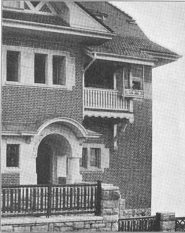
Abb. 24. Partie vom Eingang der Villa «Haldegg» in Zürich V. Architekten Pfleghard & Haefeli in Zürich.
