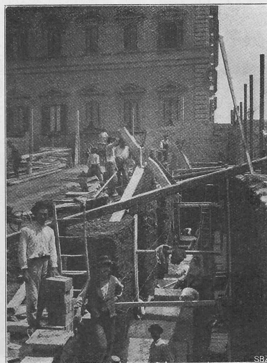
Abb. 20. Mauern der Fundamentbögen über den Pfeilern.
