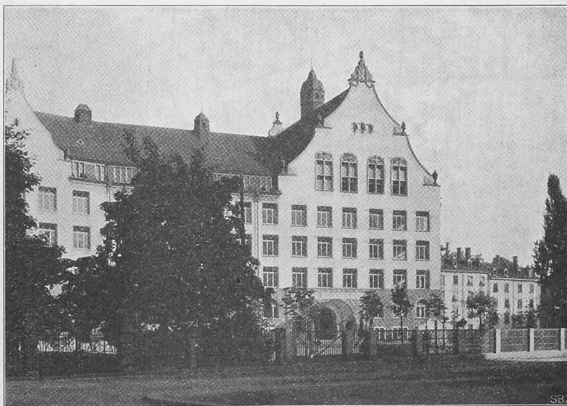
Abb. 2. Ansicht der Hauptfassade des Hadwigschulhauses in St. Gallen.
