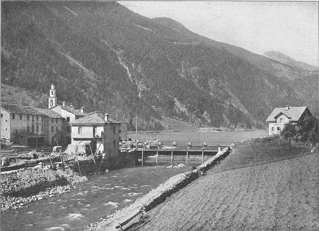
Abb. 3. Stauschleuse beim Austritt des Poschiavino aus dem See.
