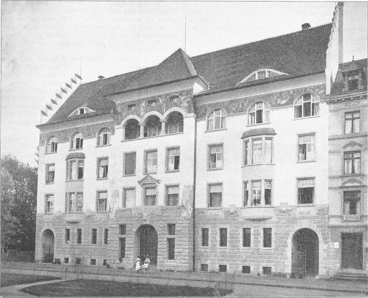
Abb. 4. Ansicht der Hauptfassade des Gebäudes.
