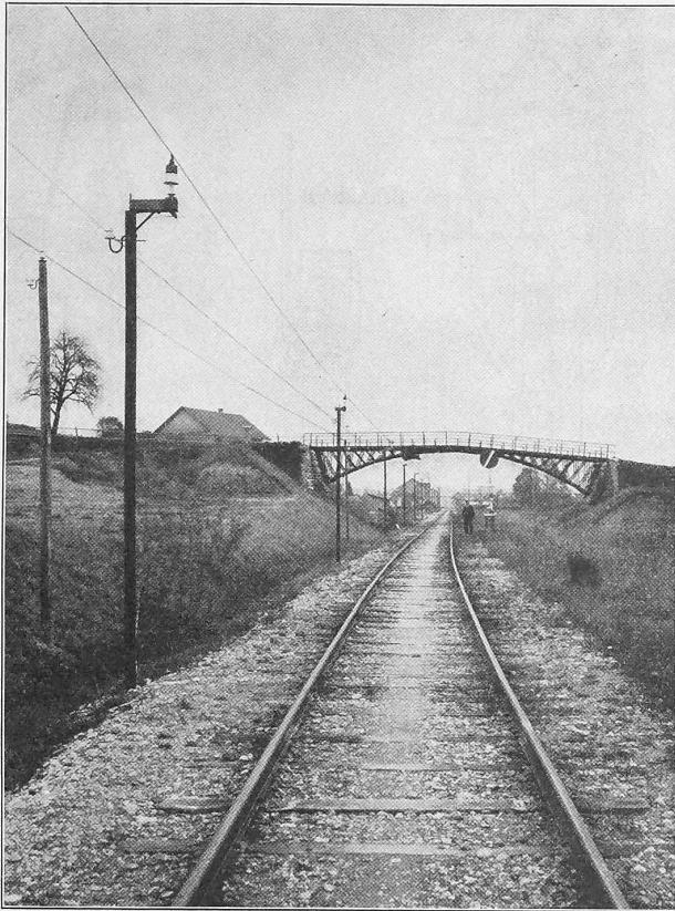
Abb. 14. Unterfahrung einer Wegbrücke bei Seebach.
