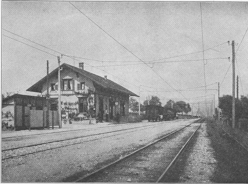
Abb. 20. Seitliche Drahtbestreichung im Bahnhof Regensdorf.
