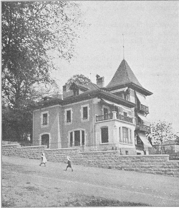
Fig. 16. La maison Siegfried à Lausanne. Architectes MM. Verrey & Heydel, Lausanne.
